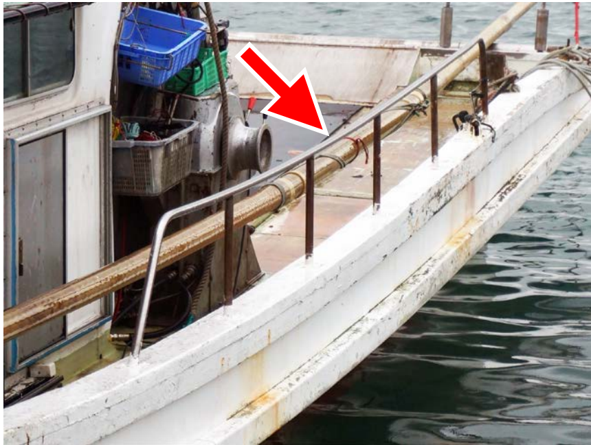
手すりの設置例①
